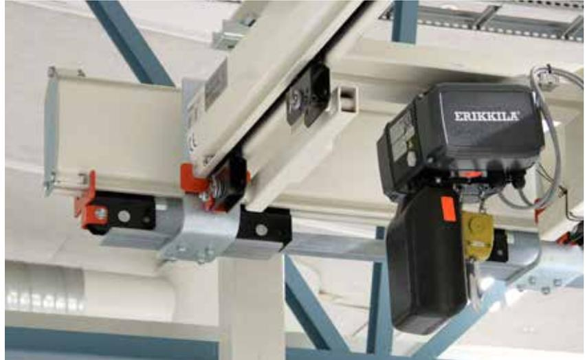
Här visar vi den mest kompakta standardlösningen. Ett lastsystem med upphöjd dubbelbalk och med en förhöjd brygga för telfer. Detta ger maximal lyfthöjd och minsta bygghöjd.
